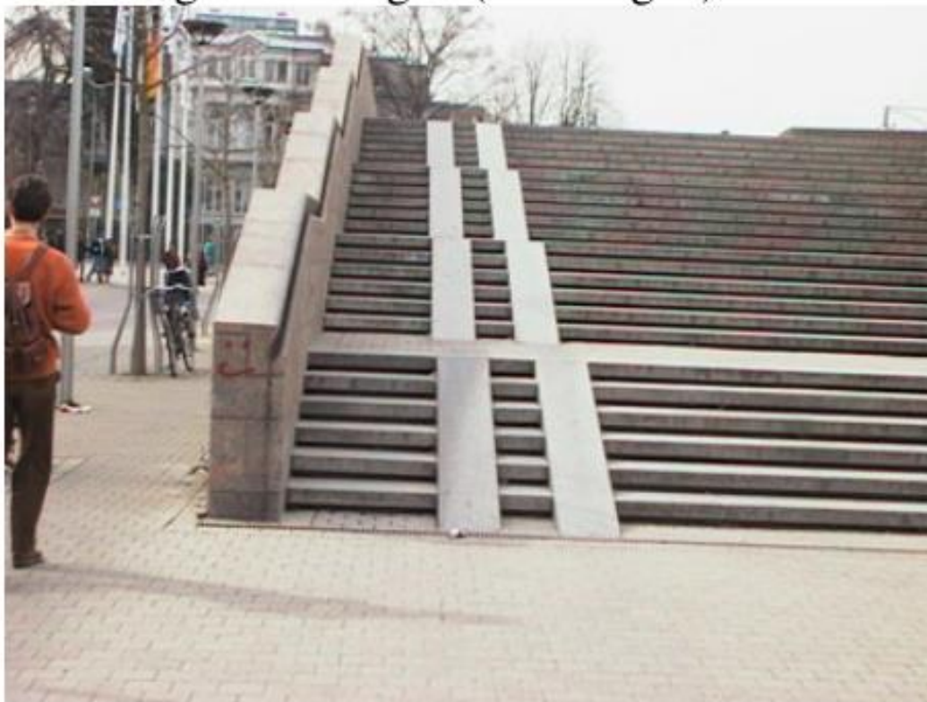
Goulotte double au niveau d'un large escalier
