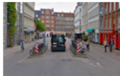
▲ Copenhague (Danemark), Guldbergsgade : la rue se resserre pour les voitures, qui ne peuvent se croiser (écluse) et doivent ralentir, tandis que les vélos bénéficient d'un cheminement latéral (bypass) confortable de part et d'autre de l'écluse
