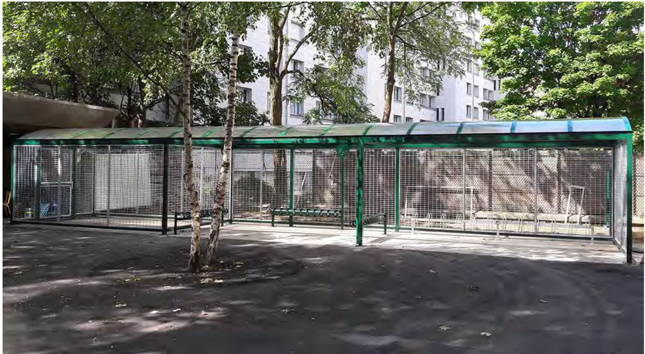
Un garage à vélos abrité dans une école de Montrouge (92). Il serait parfait avec des arceaux à la place des pincés-roues ! ©AbriPlus
