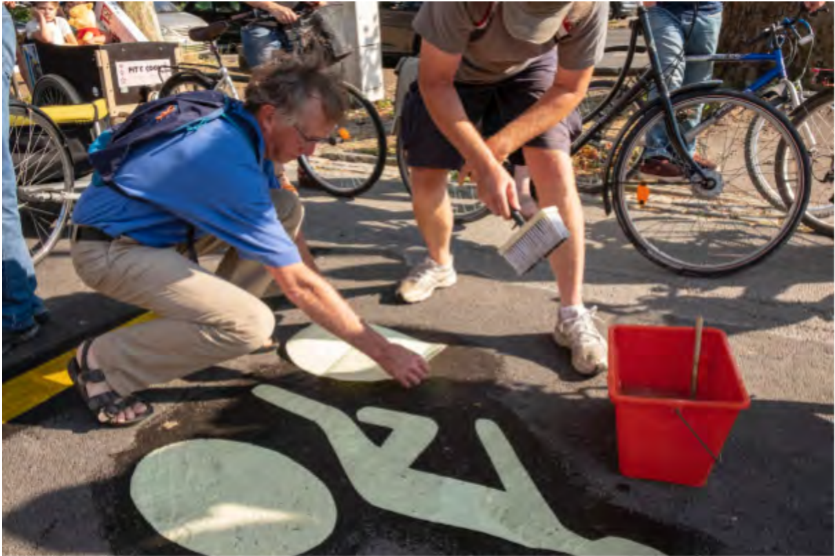
Véloxygène pose la signalisation temporaire au sol pendant les travaux à la place de la Métropole Photo Dominique Levesque pour Véloxygène
