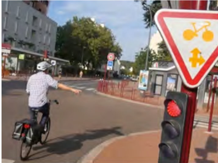
Cédez-le-passage cycliste au feu à Sceaux. Ici pour 2 mouvements (tout droit et tourne-à-droite), la ville est célèbre pour ses panneaux à 3 degrés de libertés.
