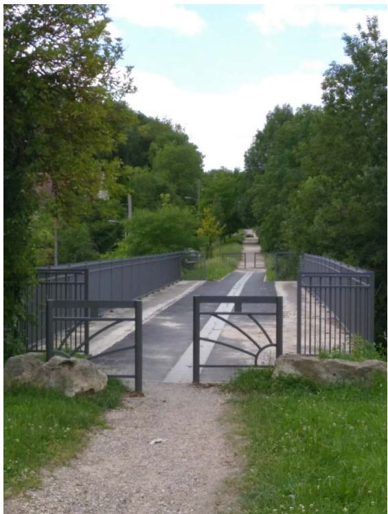
Figure 3: Avenue verte, viaduc au-dessus de la rue de Vallée, Jouy-le-Moutier
